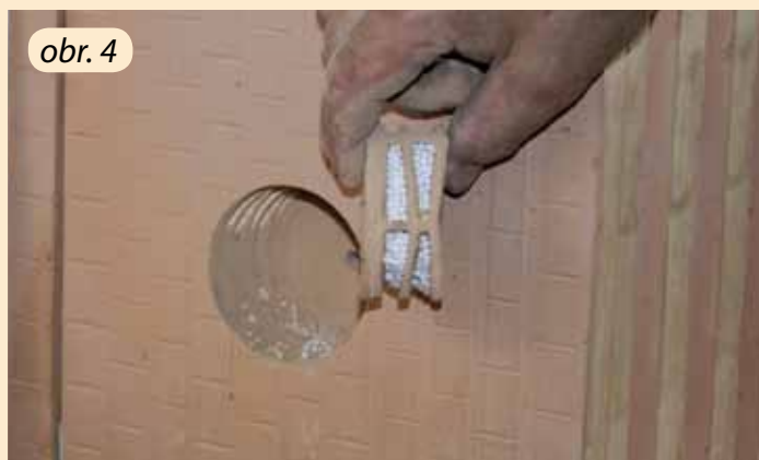
Cihelný blok HELUZ FAMILY 50 2in1 s dokončeným otvorem pro elektroinstalaci.
