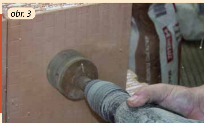
Vytváření elektroinstalačního otvoru jádrovým vrtákem do cihelného bloku HELUZ FAMILY 50 2in1.
