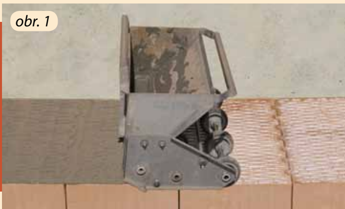
Celoplošné lepidlo HELUZ nanesené na cihelné bloky HELUZ FAMILY 50 2in1.
